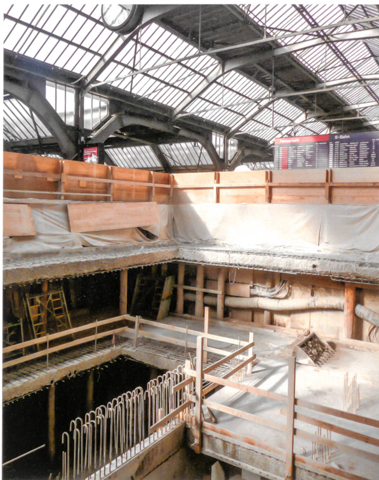
Eine Ingenieurleistung der Superlative: Bau der Durchmesserlinie Zürich mitten in der Stadt und bei vollem Bahnbetrieb.
