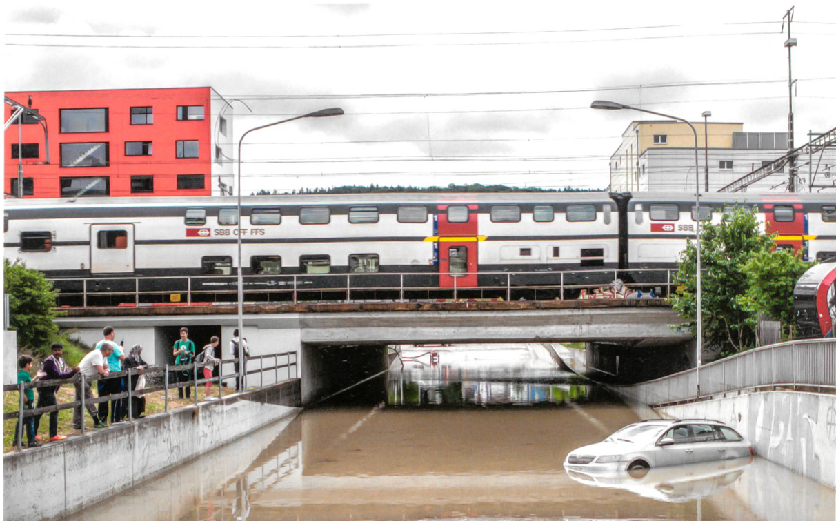
Wenn bei starken Regenfällen die Wassermengen an der Oberfläche abfliessen oder aus der überlasteten Kanalisation austreten, werden aus kleinen Ereignissen plötzlich Grossrisiken. Ausfälle von wichtigen Infrastrukturen wie Strassen oder Knotenpunkte der SBB können zu mehrtägigen Behinderungen der gesamten Wirtschaft führen. (Strassenunterführung in Schlieren ZH, Juni 2015.)
