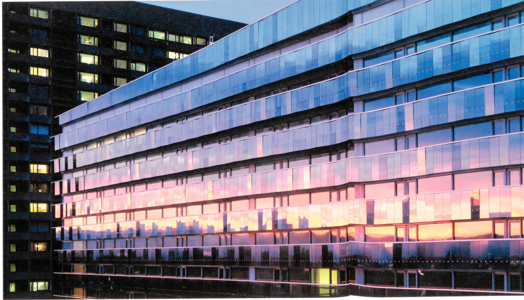
Glashaut mit Stufen und Winkeln: Der halbhohen, semitransparenten Brüstung folgt eine ebenfalls durchgängige Fensterfront; der Energiedurchlass wird über eine unterschiedliche Glasqualität spezifiziert.
