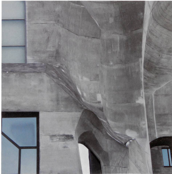
Die originale Sichtbetonfassade wurde 2014–2015 verhältnismässig und unter Einhaltung der denkmalpflegerischen Anforderungen bearbeitet (4150 m 2 ). Mit einem Preis von 85 Fr./m 2 Sichtbetonfläche waren die Arbeiten auch kostengünstig (exklusive Gerüstkosten von 65 Fr./m 2 , die der Instandsetzung des Dachs zugeordnet wurden).
