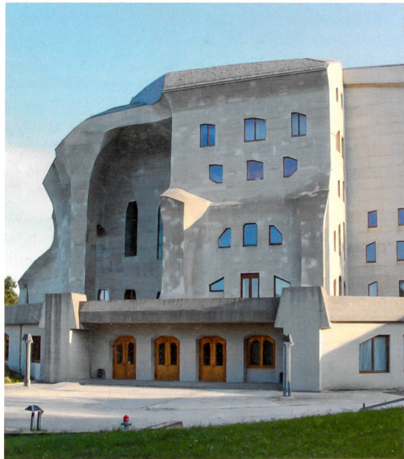
Goetheanum: Formensprache der Betonskulptur mit inhärenter Schalbrettstruktur und Licht-Schatten-Effekten.
