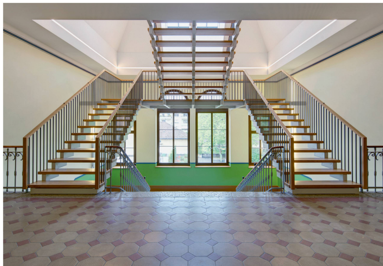
Grosses Länggassschulhaus in Bern: Übergang vom bestehenden Treppenhaus in die neu konstruierte Treppenanlage zum ausgebauten Dachgeschoss.
