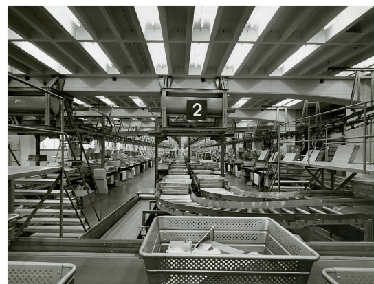
Bandanlagen, Kreisförderer und Paternoster des Quelle-Versandzentrums mussten gesteuerte Abläufe erfüllen.
