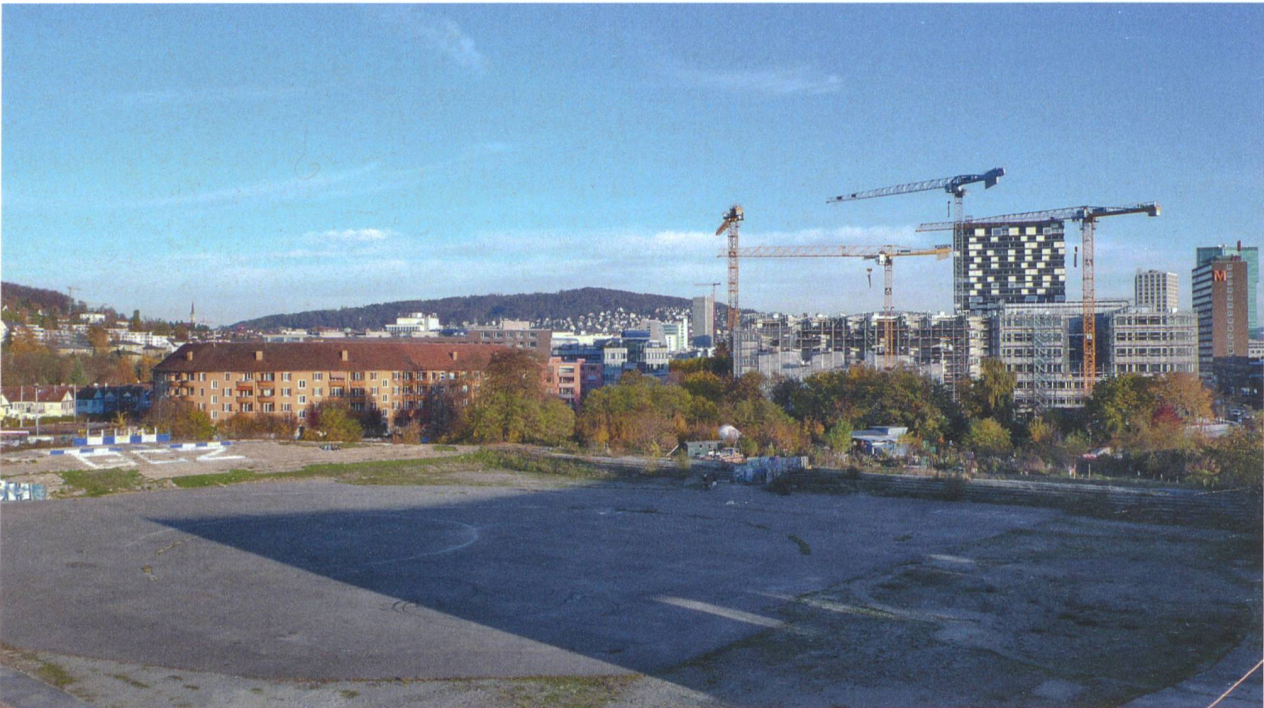
Auf dem Hardturm-Areal beginnt mit dem Investorenstudienauftrag eine neue Planungsphase.
