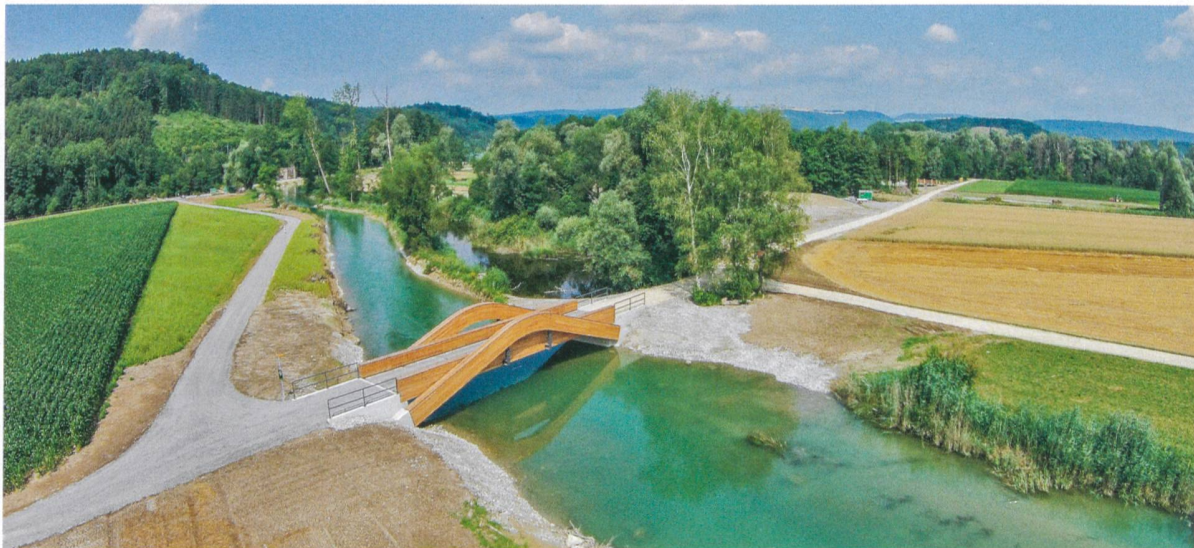
Luftaufnahme der kleineren 18-Tonnen-Brücke in der Aue Chly Rhy bei Rietheim AG.
