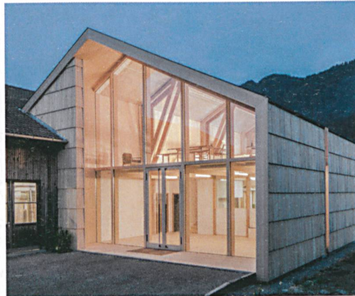
Tischlerei Mohr Andelsbuch Architekt: Andreas Mohr, Tragwerksplanung: merz kley partner ZT GmbH, Tragkonstruktion: BauBuche GL70
