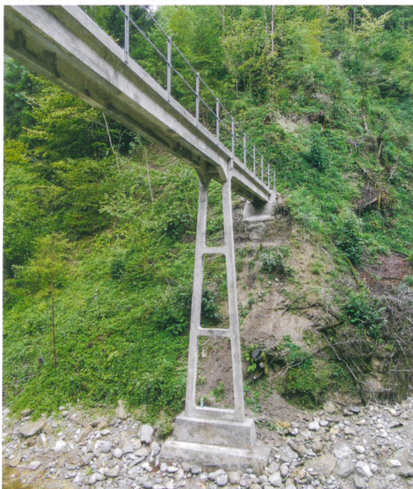
Die Hebeltobelbrücke Uznach nach der Instandsetzung.
