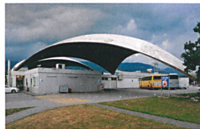
Oben: Isler-Hängeschale im Bauzustand (Hallenschwimmbad Brugg, 1981). Darunter: Isler-Hängeschale im Endzustand (Deitingen, 1968; Foto aktuell).
