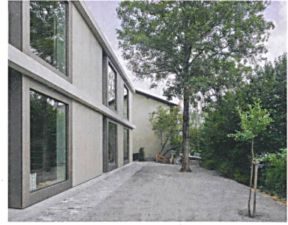
Markante Profilierungen und grosszügige Fensterflächen prägen das schlichte zweigeschossige Volumen.
