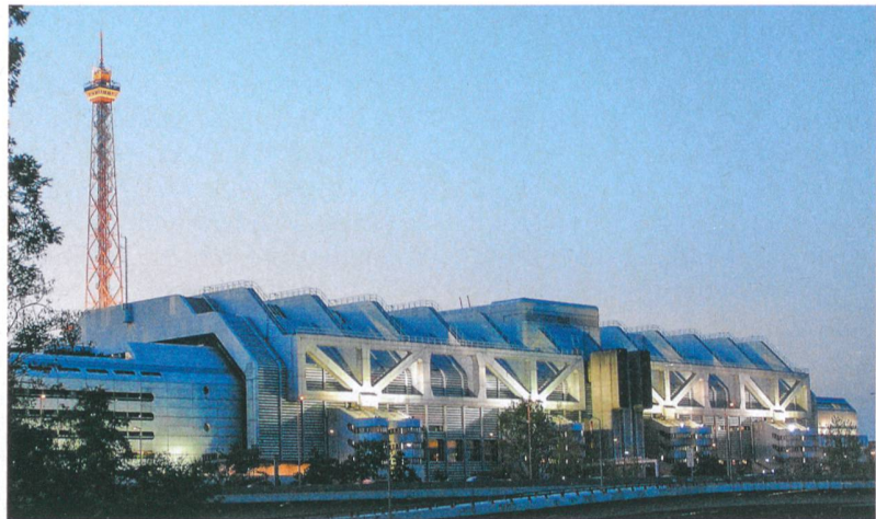
Das Internationale Congress Centrum Berlin ICC, Ostseite zur Autobahn. Links im Hintergrund der Funkturm im Messegelände (1924–1926, Heinrich Straumer).
