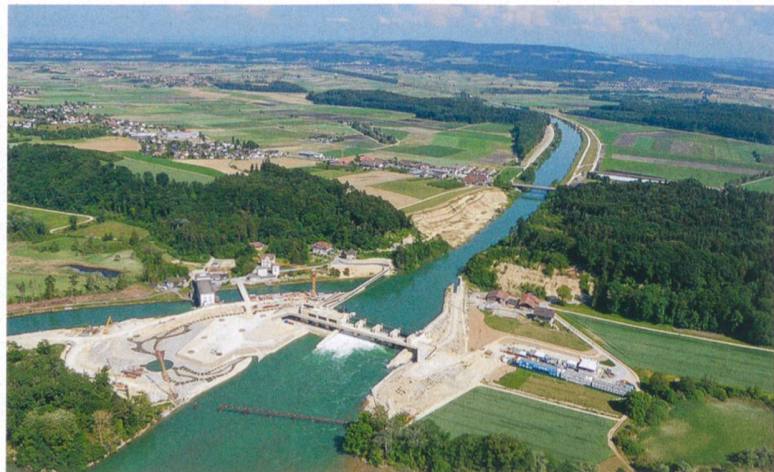
Mündung der Aare in den Bielersee, im Vordergrund das neue Kraftwerk, dahinter der Hagneckkeinschnitt mit dem abgetragenen Fels (links oben).
