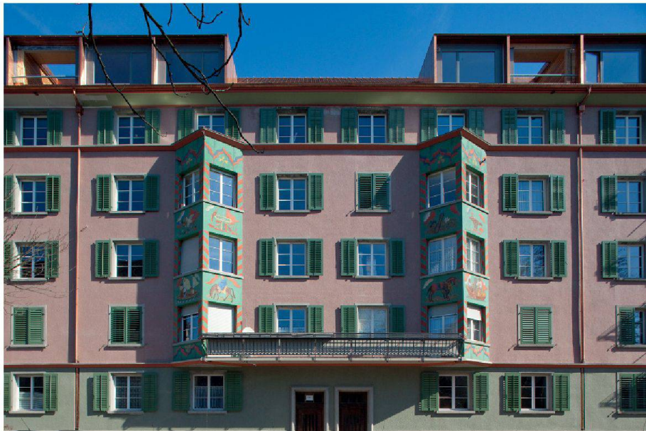
01 Die Siedlung Sihlfeld ist eines der beispielhaften Zürcher Erneuerungsprojekte. Die Lukarnen der Dachgeschosswohnungen sind strassenseitig die einzigen sichtbaren Eingriffe. (Foto: Susanne Völlm)
