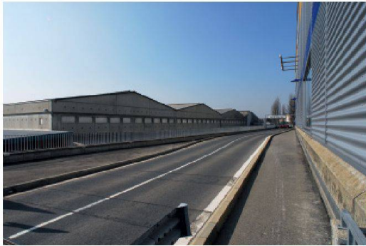
Strassenraum in Lausanne West: noch kein Ort zum Verweilen. (Foto: Franziska Werren / SDOL)
