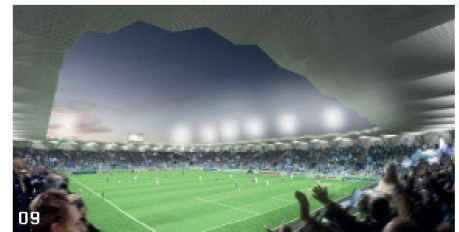
07–09 Ikonografische Erscheinung: «Beletage» von Graber Pulver Architekten. Das Fussballstadion ist als Ingenieurbauwerk erkennbar und besteht aus einem raumhaltigen gevouteten Fachwerk, das zusammen mit den Tribünenträgern eine Einheit bildet. Eine transluzente Hülle aus Metallgewebe gibt dem Bau eine wechselnde Tag- bzw. Nachtwirkung (Visualisierung und Pläne: Projektverfasser, Modellfotos: Iris Stutz)
