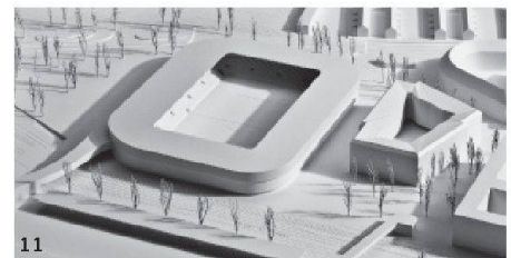
07–09 Ikonografische Erscheinung: «Beletage» von Graber Pulver Architekten. Das Fussballstadion ist als Ingenieurbauwerk erkennbar und besteht aus einem raumhaltigen gevouteten Fachwerk, das zusammen mit den Tribünenträgern eine Einheit bildet. Eine transluzente Hülle aus Metallgewebe gibt dem Bau eine wechselnde Tag- bzw. Nachtwirkung (Visualisierung und Pläne: Projektverfasser, Modellfotos: Iris Stutz)
