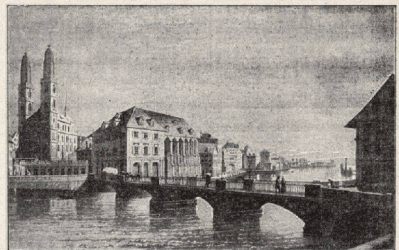
Münsterbrücke erbaut 1835—1838 Bogen zu 49 Fuss Spannweite
