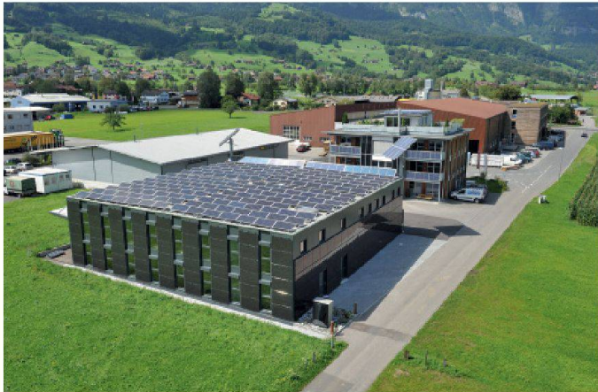
01 Der Plusenergiebau in Gams (atm3, Grabs) verfügt über zwei fassadenintegrierte PV-Anlagen, eine aufgeständerte Dachanlage und zwei Nachführsysteme, die 60.6 kWp leisten (Fotos: Schweizer Solarpreis 2011)
