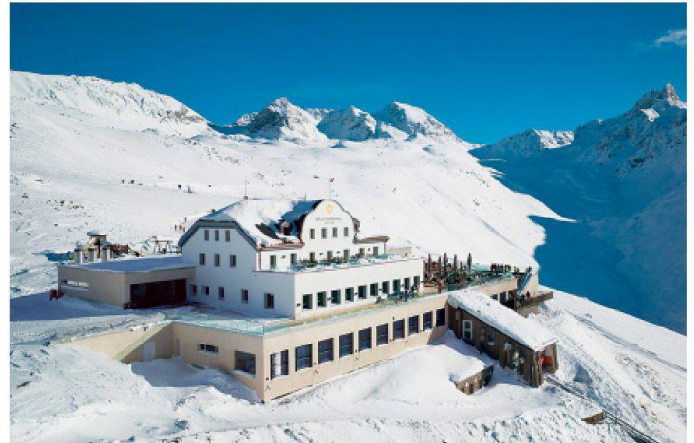
02 Auf 2456m Höhe erreicht das Plusenergiehotel in Samedan (Fanzun Arch. + Ing., Chur) durch die Kombination von Flach- und Röhrenkollektoren und einer PV-Anlage eine Eigenenergieversorgung von 105%
