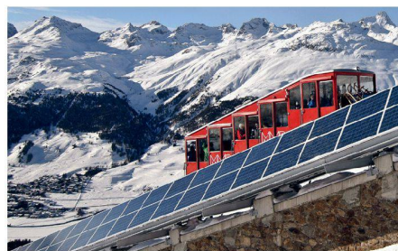
02 Die Fotovoltaikanlage produziert den Strom für die Wärmepumpe (Foto: Fanzun AG)
