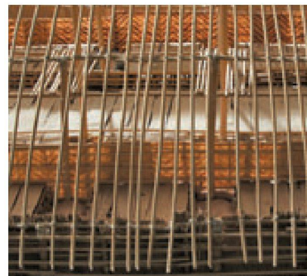
01+02 Modell und Konstruktionsdetail: Langhaus der Kaluli aus Papua-Neuguinea. Die Häuser sind durch die Sippe gemeinschaftlich aus roh belassenen Stämmen erstellt, mit Lianen verkleidet und von bis zu 60 Personen bewohnt. Es handelt sich um grosse Einraumhäuser auf Stelzen. So werden Schäden aus Überschwemmungen vermieden, und die Konstruktion ist ringsum effizient belüftet (Fotos: vinipphoto, Virginie Otth und Nicolas Lieber)
