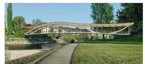
11 Gedeckte Holzbrücke mit unterspannter Bogenkonstruktion
