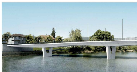
07 «Houdini»: Die Brücke besteht aus einem zweistegigen vorgespannten Plattenbalken mit schlanken, nach innen geneigten Stegen. Die Trägerhöhe nimmt in den Seitenfeldern linear gegen die Pfeiler hin zu, im Mittelfeld ist sie parabolisch überhöht. Die Pfeiler sind im oberen Teil Y-förmig aufgelöst
