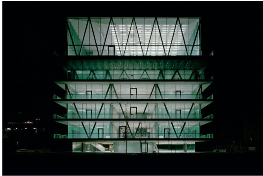
Nachtsicht des Schulhauses Leutschenbach: Die Tragkonstruktion ist gut zu erkennen (Foto: Walter Mair, Ausschnitt: Red.)
