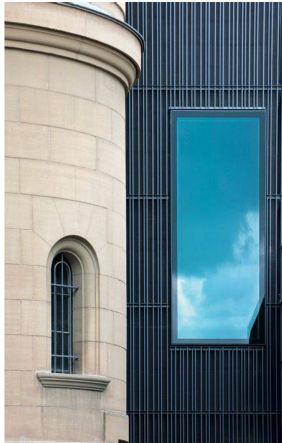
Die Stelenfassade aus vertikalen Stahl-Rundstäben als Rahmen für das Fenster, im Dialog mit der Vergitterung beim Altbau (Foto: Alexander Gempeler)
