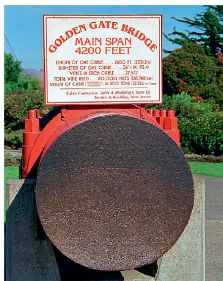
02 Stahlkabel der Golden Gate Bridge mit einem Durchmesser von 92 cm, bestehend aus über 27 000 Einzeldrähten
