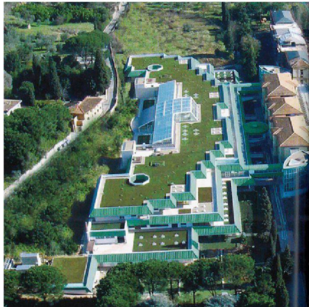
01 Das Meyer-Kinderspital in Florenz wurde erneuert und ist seit Ende 2007 wieder in Betrieb (Bild: aus dem Archiv der Architekten CSPE Florenz; Romano del Nord)
