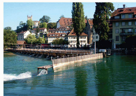
Stirnwehr mit 3.5 Meter langen Holznadeln (Bild: Lukas Denzler)
