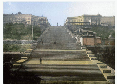
12 «Brazil»: Potemkinsche Treppe Odessa (e6) (Bild: de.wikipedia.org/wiki/Potemkinsche_Treppe)
