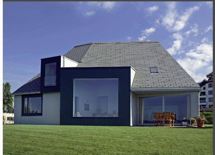
Pool Architekten, Zürich
