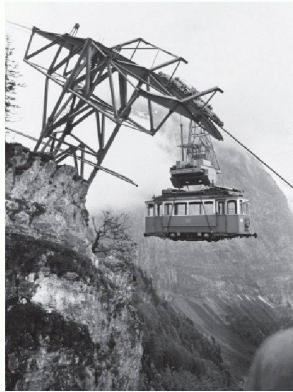
Am 2. Juni 1960 wurden zwei ausrangierte Zürcher Tramkompositionen mit der Schwerlast-Luftseilbahn der Kraftwerke Linth-Limmern transportiert. Die Bergstation der Bahn liegt 1055 m über dem Talboden von Tierfehd bei Linthal GL. Die Trams dienten als Stollenbahn im Erschliessungstunnel der 1968 fertiggestellten Staumauer Limmernboden. Die abgebildete 18-t-Seilbahn wurde nach Abschluss des Kraftwerkbaus demontiert. An ihrer Stelle steht heute eine kleinere Einkabinebahn für den Personentransport in Betrieb (Bild: KEYSTONE / Photopress-Archiv / Schoenwetter)
