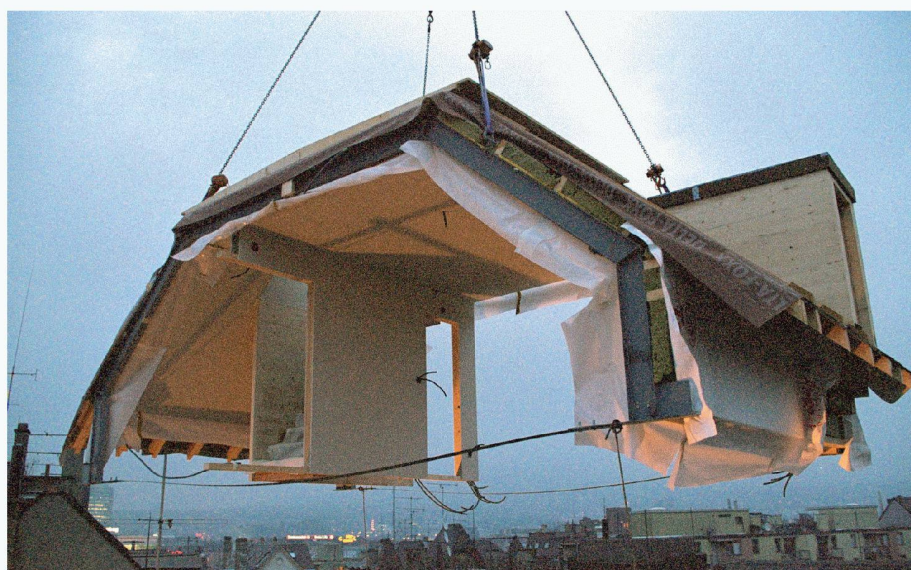
01 Die Forschung arbeitet unter anderem an Lösungen, um die energetische Sanierung von Altbauten zu erleichtern. Eine Variante sind vorgefertigte Dachmodule, in die Anlagen zur Nutzung von Sonnenenergie und die Komfortlüftung bereits integriert sind, wie sie bei der Sanierung eines Gebäudes an der Magnusstrasse in Zürich eingesetzt wurden (Bild: K. Viridén, Zürich)
