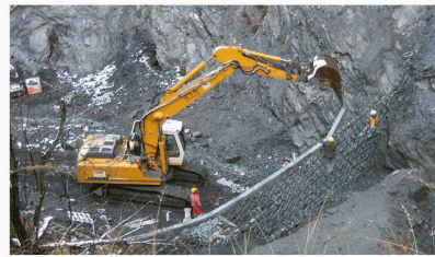
Montage der Barrieren mit leichter Bohrmaschine und Bagger
