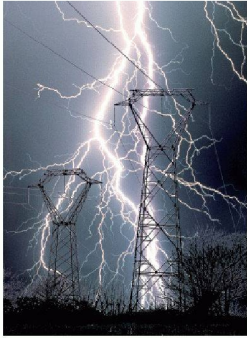
Höchstspannungen: Übertragungsleitungen (380 kV, Stromstärken um 1000 A) und Blitze (einige Millionen V, Stromstärken um 20000 A) (Bild: KEYSTONE / SUNSET / Didier Pire)
