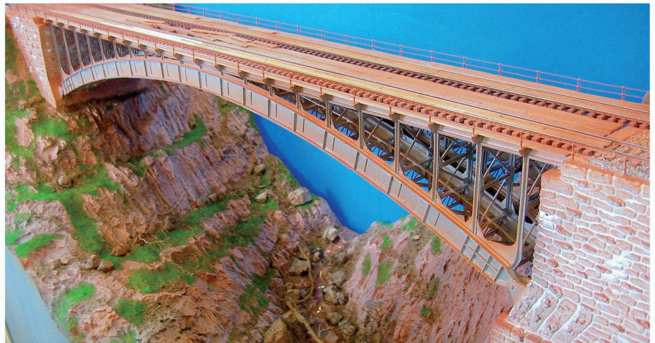
10 Modell 1:87 der Rorbachbrücke. Ansicht der Unterwasserseite vom Widerlager Nord aus. Zustand zwischen 1893 und 1909 (Doppelspurausbau, keine Diagonalstreben) (Modellbau und Bild: Erich Schmied/SBB Projekt-Management Luzern)
