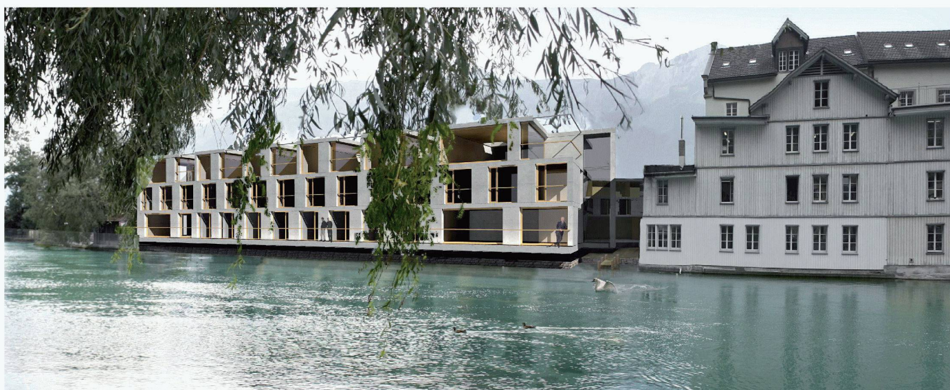
03 Blick über die kleine Aare auf die «waterfront» und das historische Mühlegebäude (L2A – Lengacher Althaus, Unterseen-Interlaken)
