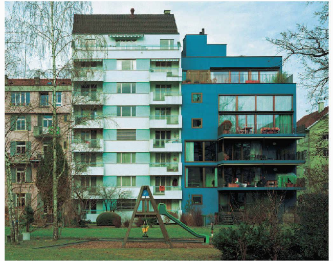
Mehrfamilienhaus Lindenstrasse, Luzern (Scheitlin-Sifrig + Partner)
