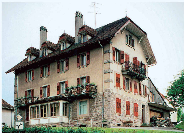
Die geschützte Maison Deillon im Quartier Belle-Croix in Romont (FR) ist widerrechtlich gesprengt worden. Nun fordert der Schweizer Heimatschutz härtere Strafnormen für die Zerstörung von Kulturgut (Bild: pd)
