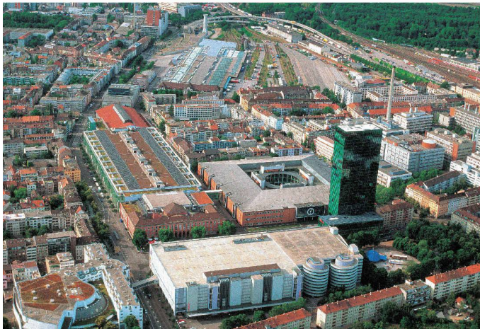
Messeplatz mit der Art-déco-Halle von Hermann Herter links und der Rundhofhalle von Hans Hofmann, die der Denkmalrat beide unter Schutz stellen will (Bilder und Pläne: Herzog & de Meuron)
