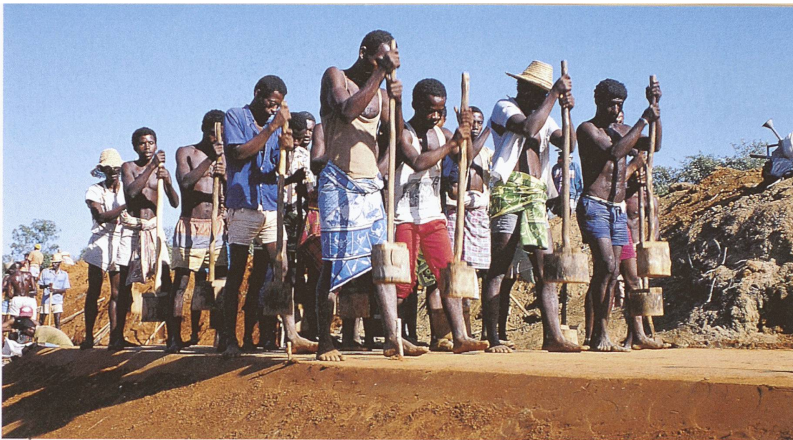
Kanalbau in Madagaskar
