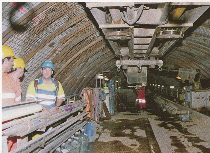
Die engen Verhältnisse und die langen Transportwege erfordern eine gut organisierte Logistik, damit der Vortrieb nicht behindert wird (Bilder: Schmid)
