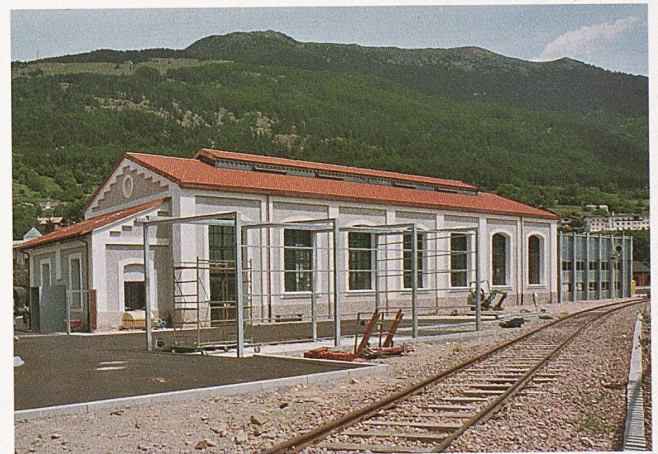
Die alte Remise von Mals wurde für die Bedürfnisse des modernen Bahnverkehrs hergerichtet und mit architektonisch eigenständigen Anbauten erweitert
