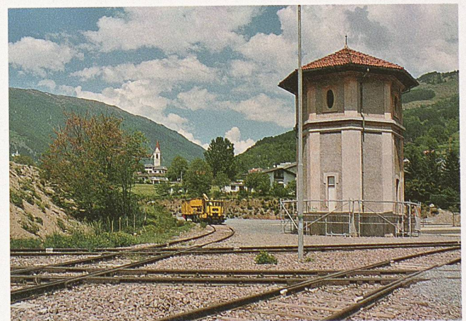
Kuriosum aus dem Dampflok-Zeitalter: Der statt einer Drehscheibe errichtete Wendestern um einen Wasserturm in Mals. Fünf Mal mussten die Dampfloks zum Wenden die Richtung wechseln, bis sie wieder vor die talabwärts fahrenden Züge gekuppelt werden konnten
