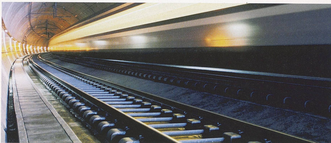
Feste Fahrbahn im Betrieb im Grauholztunnel (Bahn 2000; Bild: SBB)
