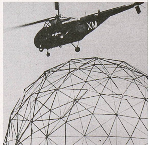
3 Bau der geodätischen Kugel in St. Louis, 1959
