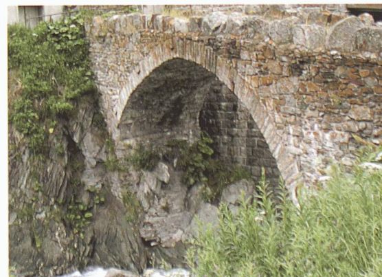
Pont à Wassen, Uri
