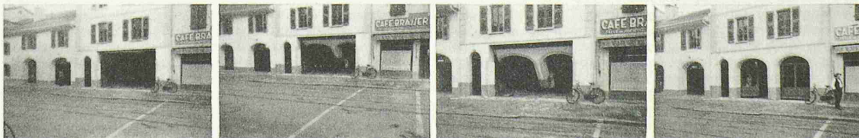
Verwandlung der Fassade eines Lastwagenbetriebes in Carouge (Genf) zur Feierabendstunde
