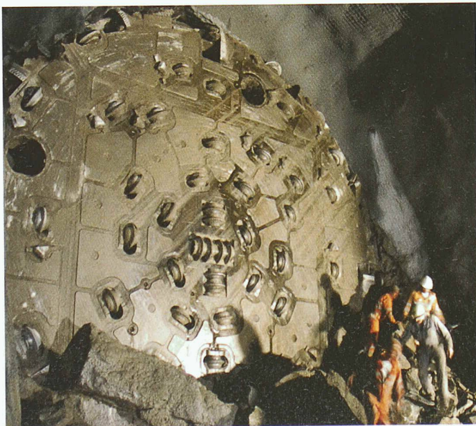
Stollendurchbruch mit Tunnelbohrmaschine (Bilder: BLS Alp Transit AG)
