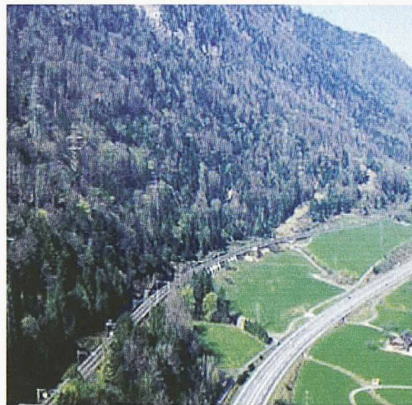
Klassischer Schutzwald an der Rigi-Nordlehne: gegen extrem steile Hangneigung, instabile Bodenbeschaffenheit und zum Schutz der Infrastruktur am Fuss der Rigi (Bild: www.viasilva.ch)
