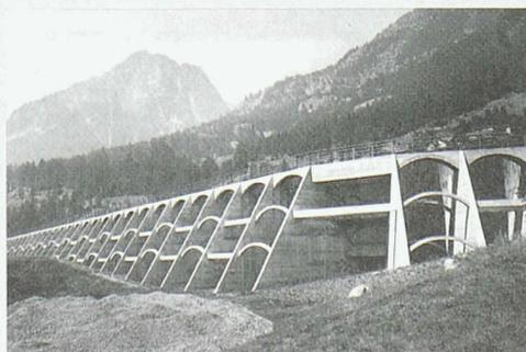
Die Staumauer des Ausgleichsbeckens «Les Marécottes» wurde 1925 in Betrieb genommen. Sarrasin löste mit der Konstruktion als Gewölbereihen-Pfeilerstaumauer mit Bögen einer Dicke von nur 12 cm eine heftige Debatte unter Ingenieuren aus.
