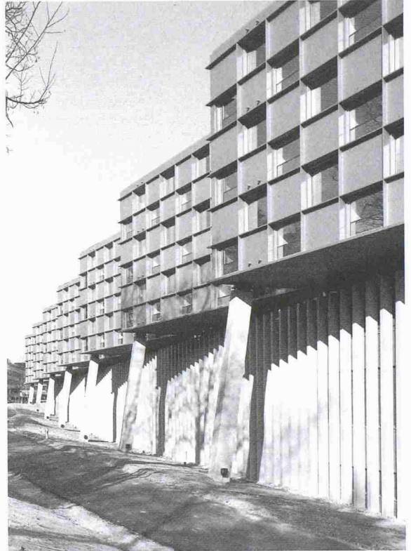
Die neue Frauenklinik des Inselhospitals Bern, entworfen von Bétrix und Consolascio: nachhaltig dank drei getrennten Bausystemen mit unterschiedlicher Lebenserwartung. Ost- (oben) und Westfassade (unten) (Bilder: Kt. Hochbauamt Bern)
