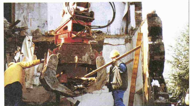
Demontage einer Wandbekleidung aus Heraklitplatten
