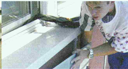
Schnelle Montage durch das einfache Einhängen der Glasplatten auf der Baustelle
