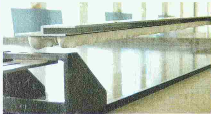
Verklebung des Einhängesystems auf die Plattenrückseite in der Vorfabrikation
