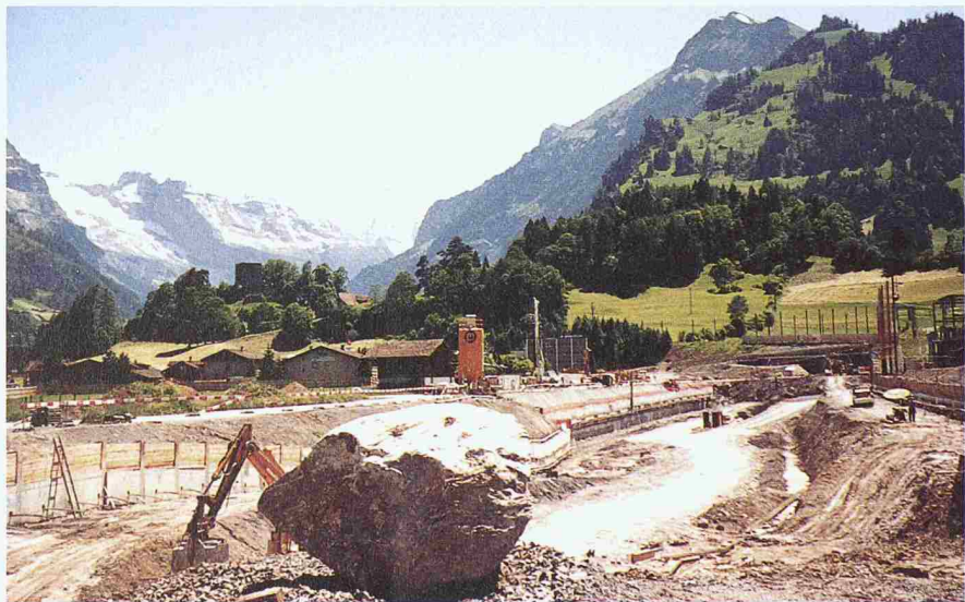
Bau der offenen Interventionsstelle bei Frutigen. Bei Unfällen erleichtert die in einem offenen Graben anstatt durchgehend im Tunnel geführte Strecke den Zugang zur Unfallstelle (Bilder: Zoppet)
