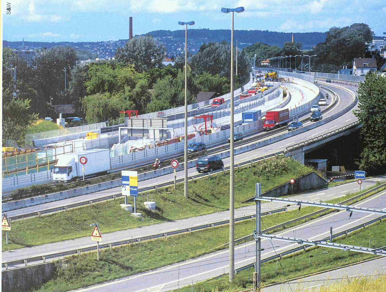
ARGE Sihlhochstrasse, Zürich. Grösste umfassende Brücken-Instandsetzung in der Schweiz
